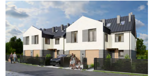
Widok od strony ulicy
